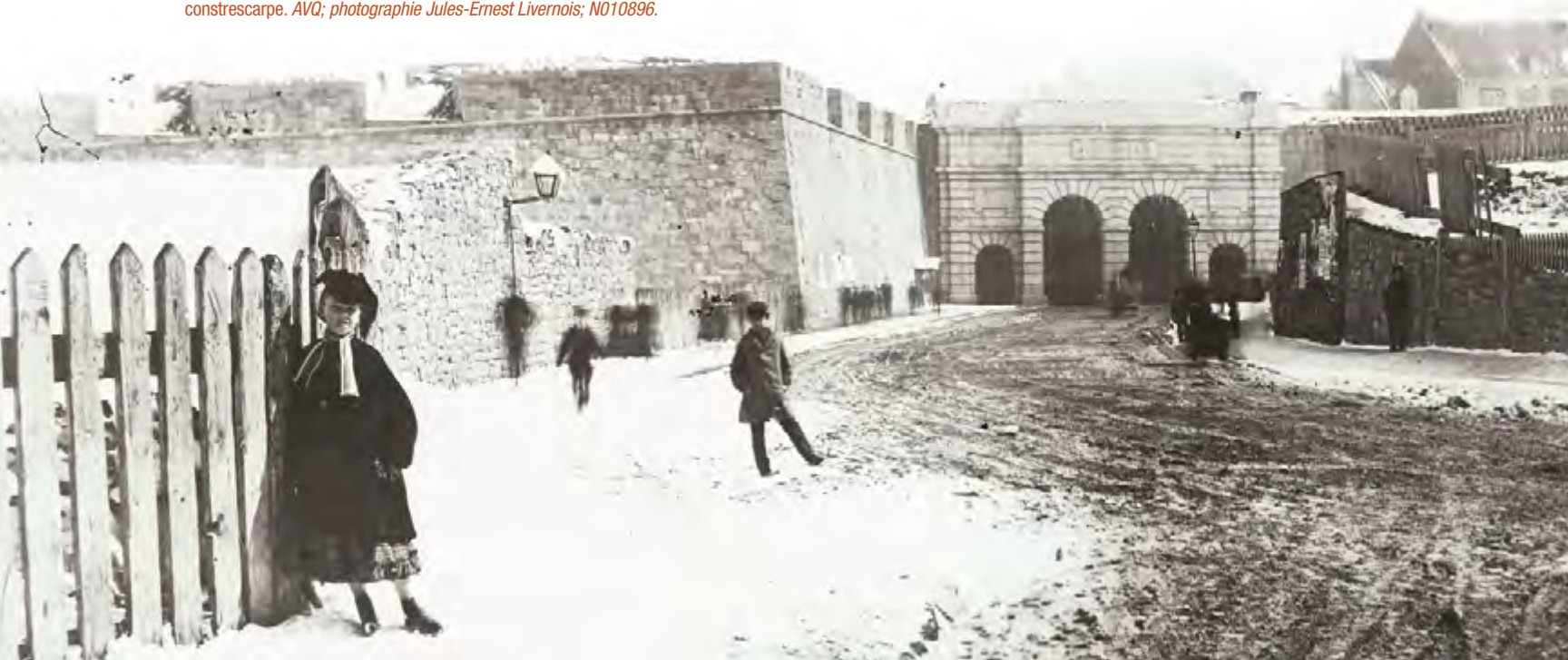
▼ La porte Saint-Jean édifée en 1867. À droite, on remarque le glacis, un talus gazonné qui prenait appui sur le mur de contrescarpe. AVQ; photographie Jules-Ernest Livernois; N010896.
