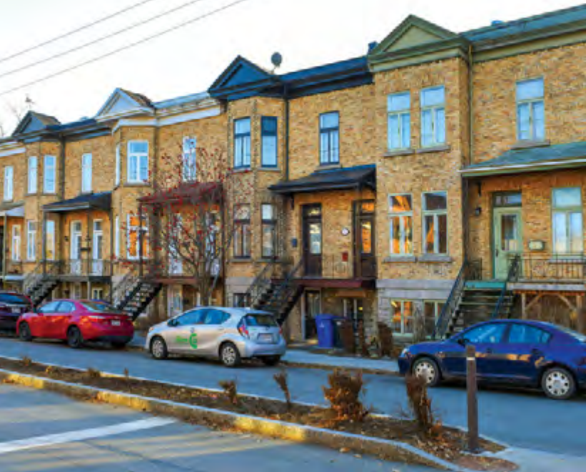
Le « bloc Forget », premier ensemble de maisons construit sur le site du Parc Montcalm. Photographie Ville de Québec.
